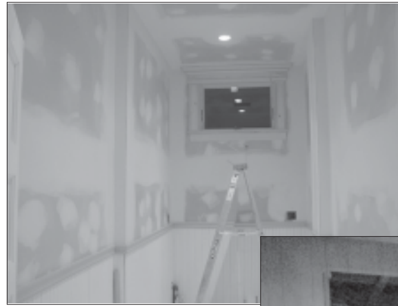
Vista del trabajo hecho en el pequeño baño con el sheetrock al cabo de nueve semanas.
